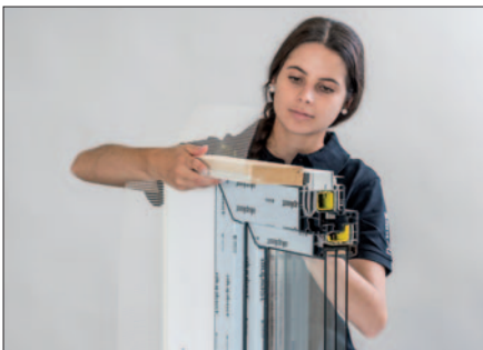
Einschieben der Leibungsplatten außen.
